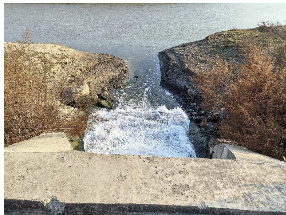
农安海格污水处理厂现有排污口
