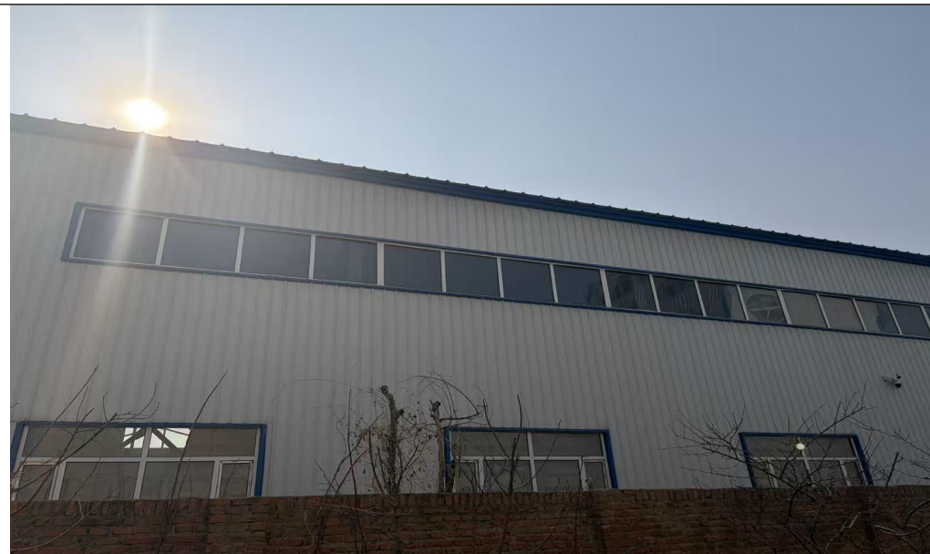
本项目西侧空置厂房
